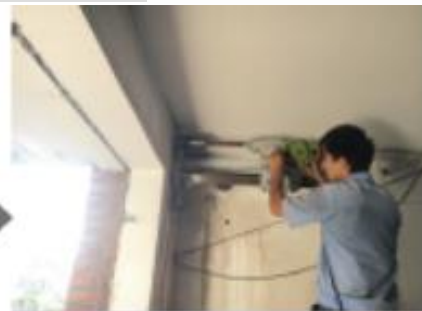
空调机、新风机管道安装
