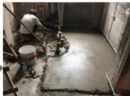
铺设厨卫地面基层
