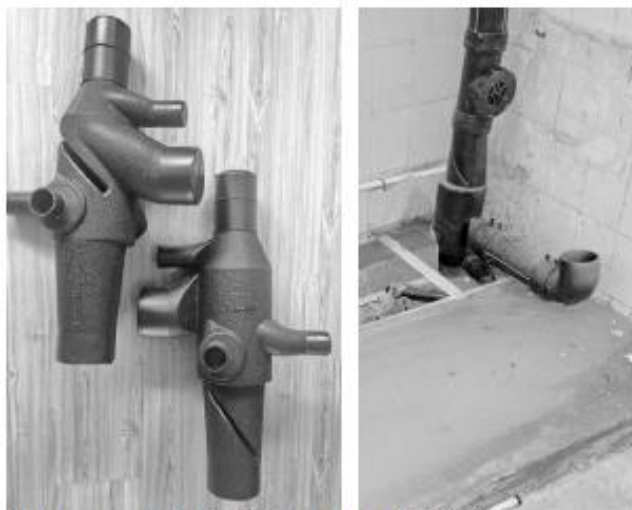
图4-6 专利管件及其现场安装
