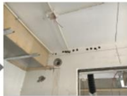
铺设电线支管
