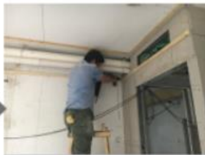
安装吊顶龙骨
