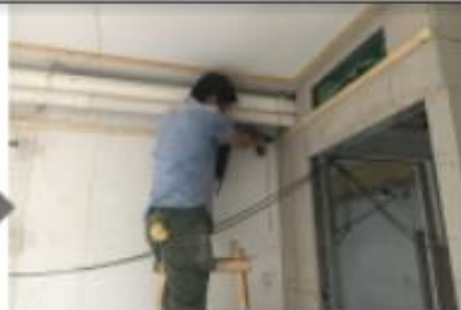
安装吊顶龙骨
