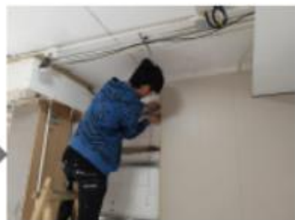
安装装饰墙板
