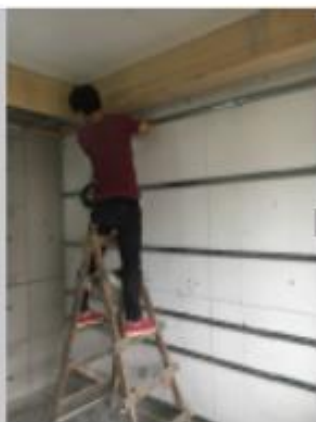
安装装饰墙面龙骨
