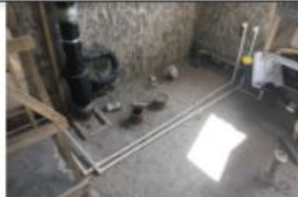
铺设给水支管
