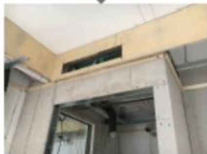
隔墙封板，立管包封
