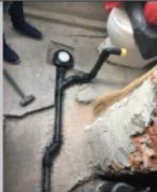
铺设排水支管和地漏
