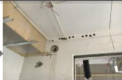
铺设电线支管
