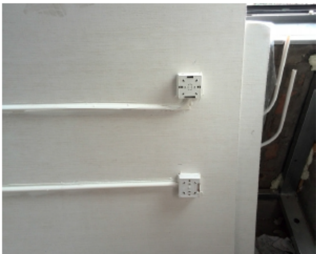
图4-8 线管在板材上定位
