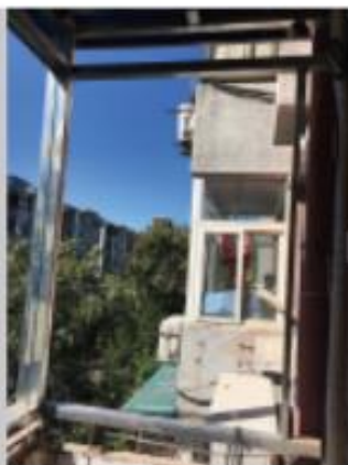
安装阳台钢结构
