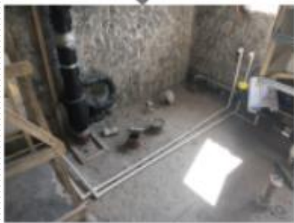
铺设给水支管
