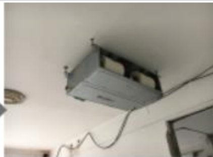
空调机、新风机安装
