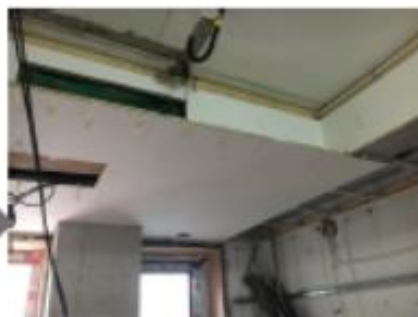
安装吊顶板
